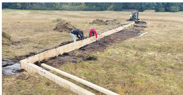
Bau der ersten Sperre in Wolfschachen im Oktober 2023. Die 2,5 Meter langen Holzbohlen werden bis in den mineralischen Untergrund gerammt, um die Wasserdichtigkeit zu gewährleisten.
