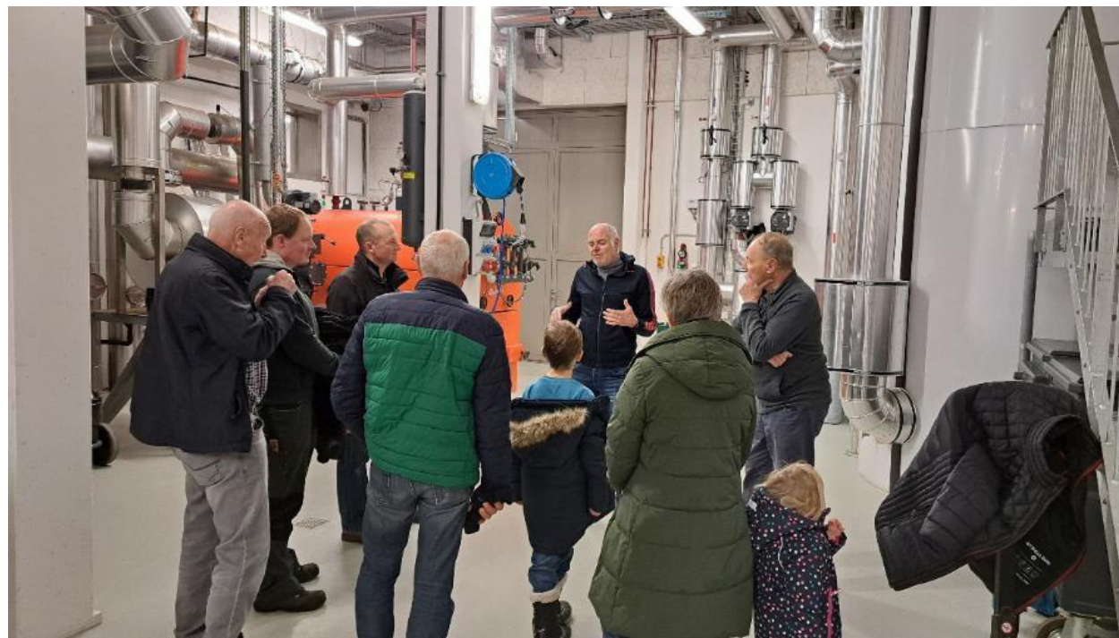
Führung in der Holzschnitzelheizung Obere Allmeind
